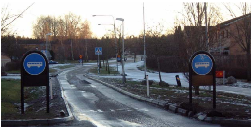
Figur 2.13 Bussgata med spårviddhinder i Lambohov, Linköping
