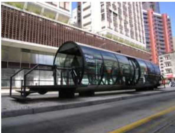
Figur 2.14 BRT-hållplats i Curitiba, Brasilien
