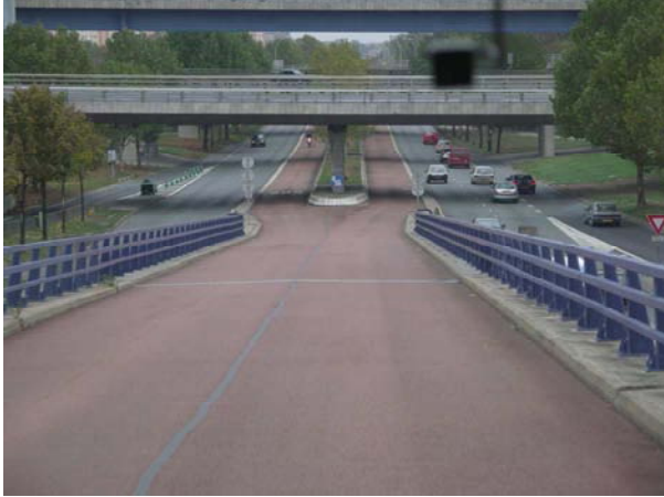
Figur 3.19 På separerad bussbana kan medelhastigheten ökas. Flyover på TWM, i Paris (Kottenhoff)
